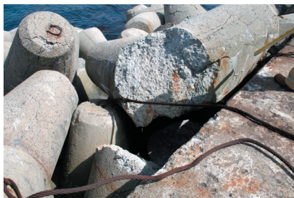
写真-12 消波ブロックの破損
