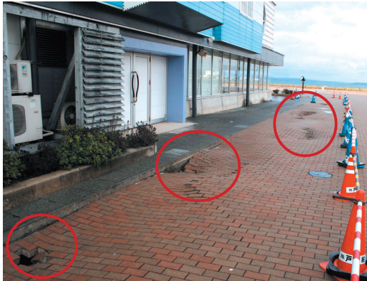
写真-5 液状化によるインターロッキングブロックの不等沈下
