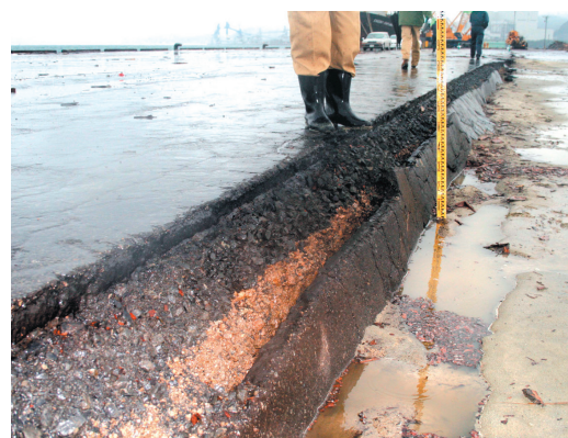
写真三 ケーソン背後の沈下（大田（1号）岸壁）
