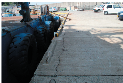
写真-13 岸壁の亀裂
