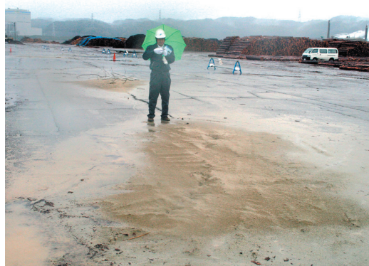
写真二 液状化の痕跡（大田（1号）岸壁）
