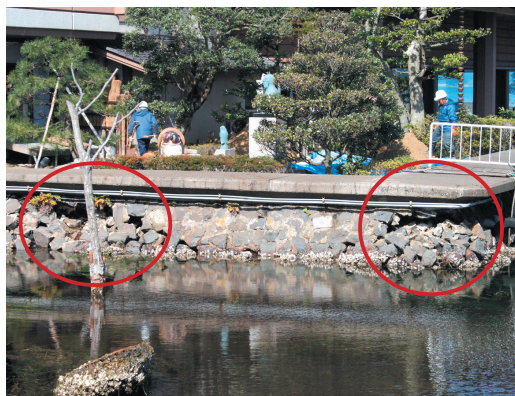
写真-9 石積護岸の崩落
